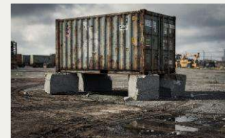
Kontener na luźnych bloczkach
